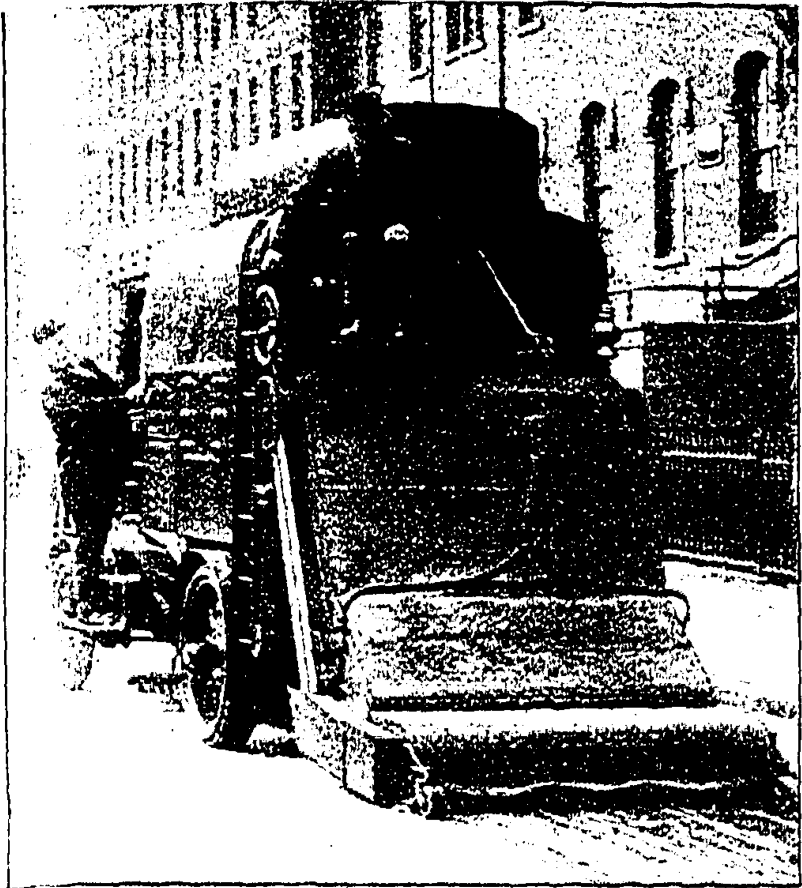
Eine neue Straßenreinigungsmaschine mit Automobilbetrieb.
