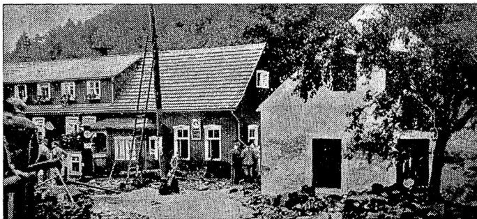
Eine in einen reißenden Bach verwandelte Straße von Dippoldiswalde (Erzgebirge).
