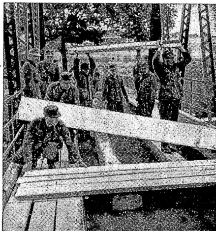
Das Aufbauwert in den besetzten Gebieten in vollem Gange. Unmittelbar nach der Befetzung haben Spezialtruppen der Wehrmacht sofort das Aufbauwert in Angriff genommen, um die Zerstörungen der Tschchen zu beseitigen. Hier sieht man Pioniere beim Verbreitern einer zu schmalen Brücke über die Moldau in der Nähe von Oberplan in Südböhmen. (Säger-Wilderdienst-M.)
