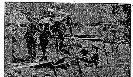
Deutsche Bioniere bauen eine Notbrücke über die Durthe in Belgien. W. Döcker-Weltbitt (W.)
