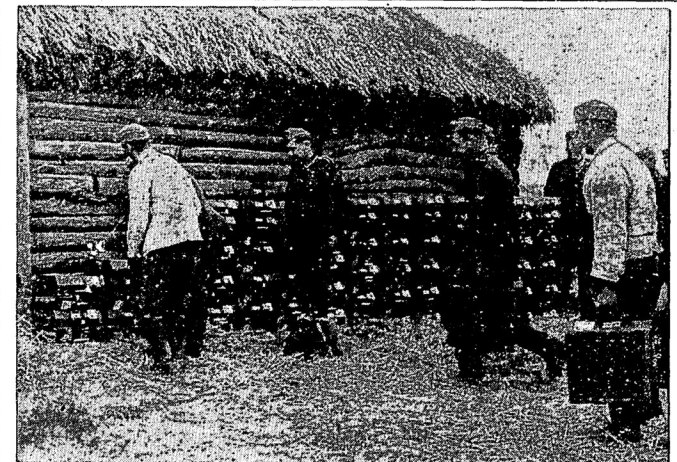
R.-Aufnahme: Kriegsberichterstatter Duder-Wb. (M.) Munition wird dicht hinter der vorbersten Front gestapelt
