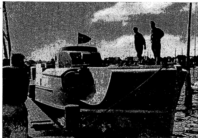
PK-Aufnahme: Kriegsberichterstatter Vorländer (Wb.) Ein Schnellboot kurz nach dem Stapellauf Der Bootskörper und die Unterverrasterarbeiten sind fertig. Die Restarbeiten erfolgen am Pier
