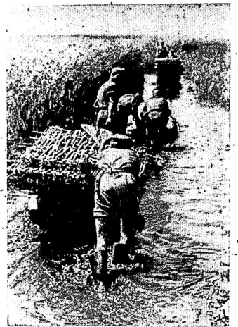
PK-Aufnahme: Kriegsberichterstatter Kühn (Wb.) Stellungsbau am Kuban-Brückenkopf Mühsam werden auf Schlauchboolen Faschinen zum Stellungsbau nach vorn geschafft
