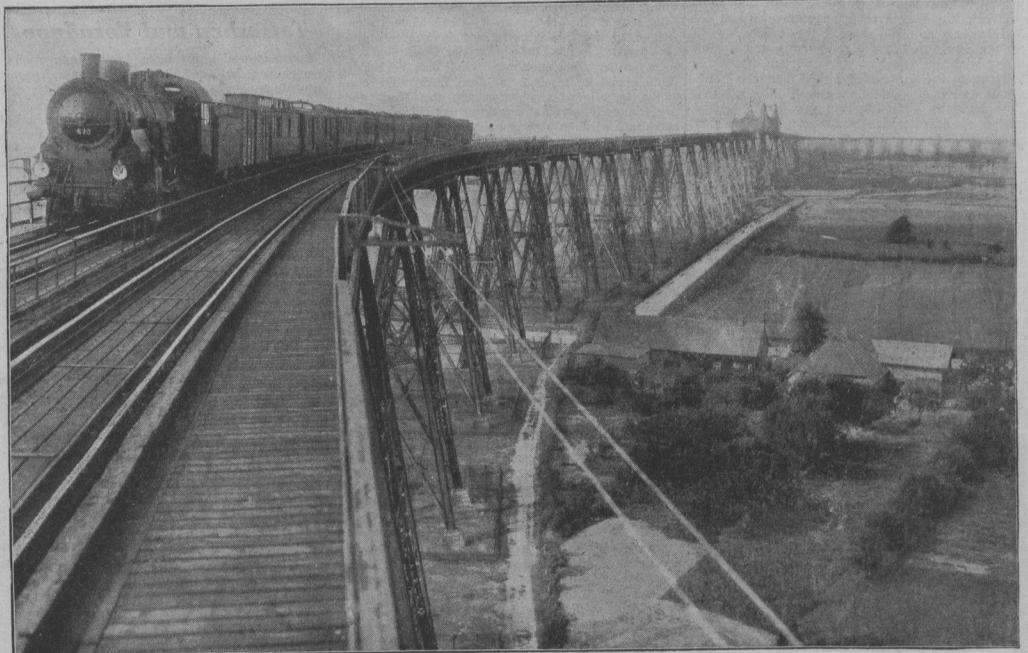
Eine bedeutende Leistung der deutschen Brückentechnik: Die eiserne Hochbrücke über den Kaiser-Wilhelm-Kanal bei Rendsburg Gesamtansicht der Brücke, die wegen der durch die gewaltige Höhe bedingte Steigung in einem grossen Bogen ausgeführt werden musste. (Siehe auch Abbildung Seite 12.)
