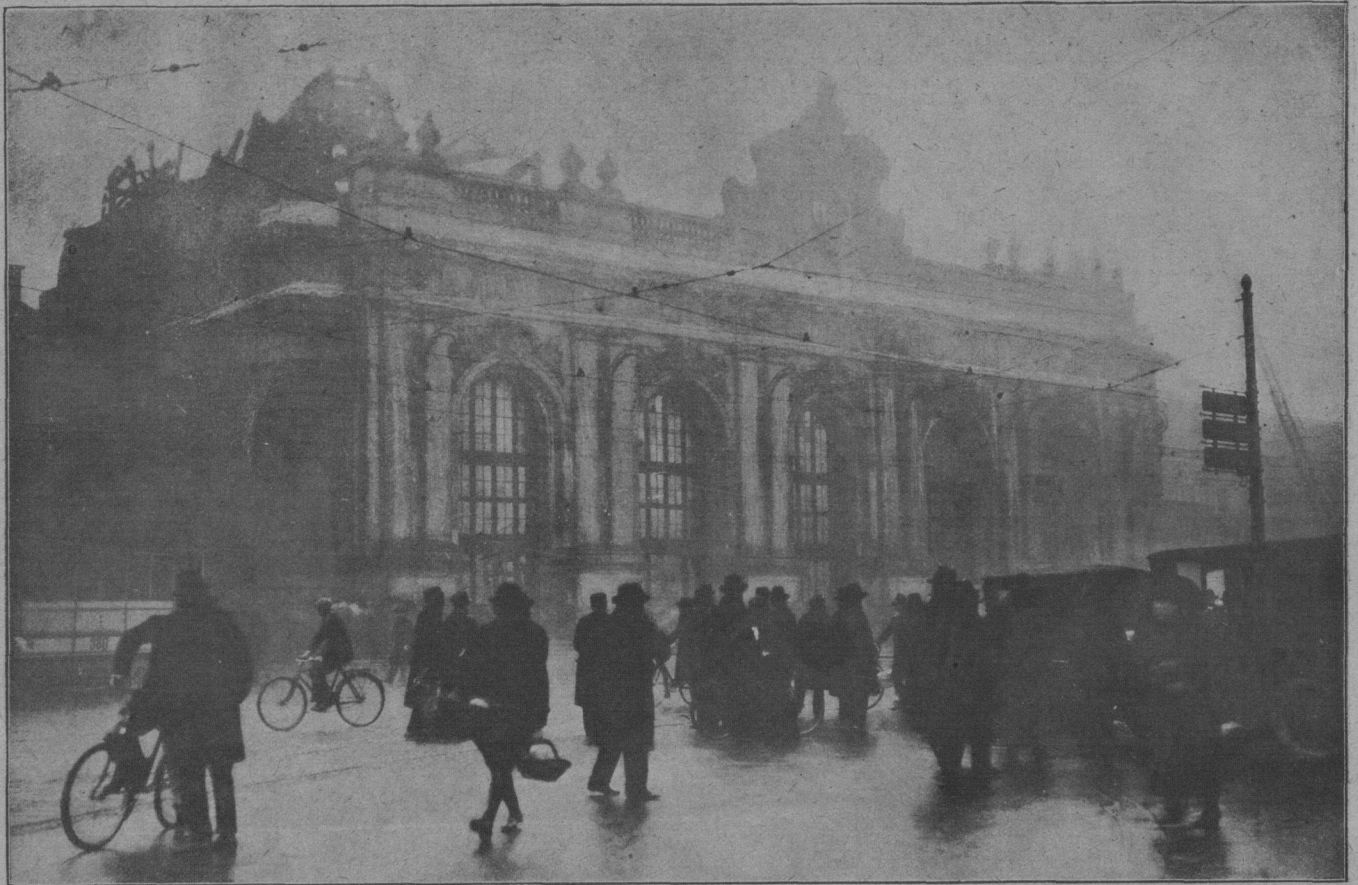
Der Brand des Mailänder Hauptbahnhofes, bei dem das Dach des Bahnhofes einstürzte und ein Teil des Gebäudes zerstört wurde. Phot. Sennecke.
