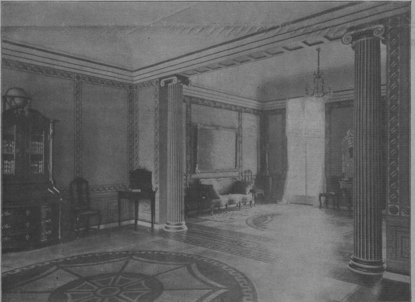
Durchblick durch die beiden Salons im Erdgeschoß des Hauses Rathenau. Aufnahmen von Kullrich.
