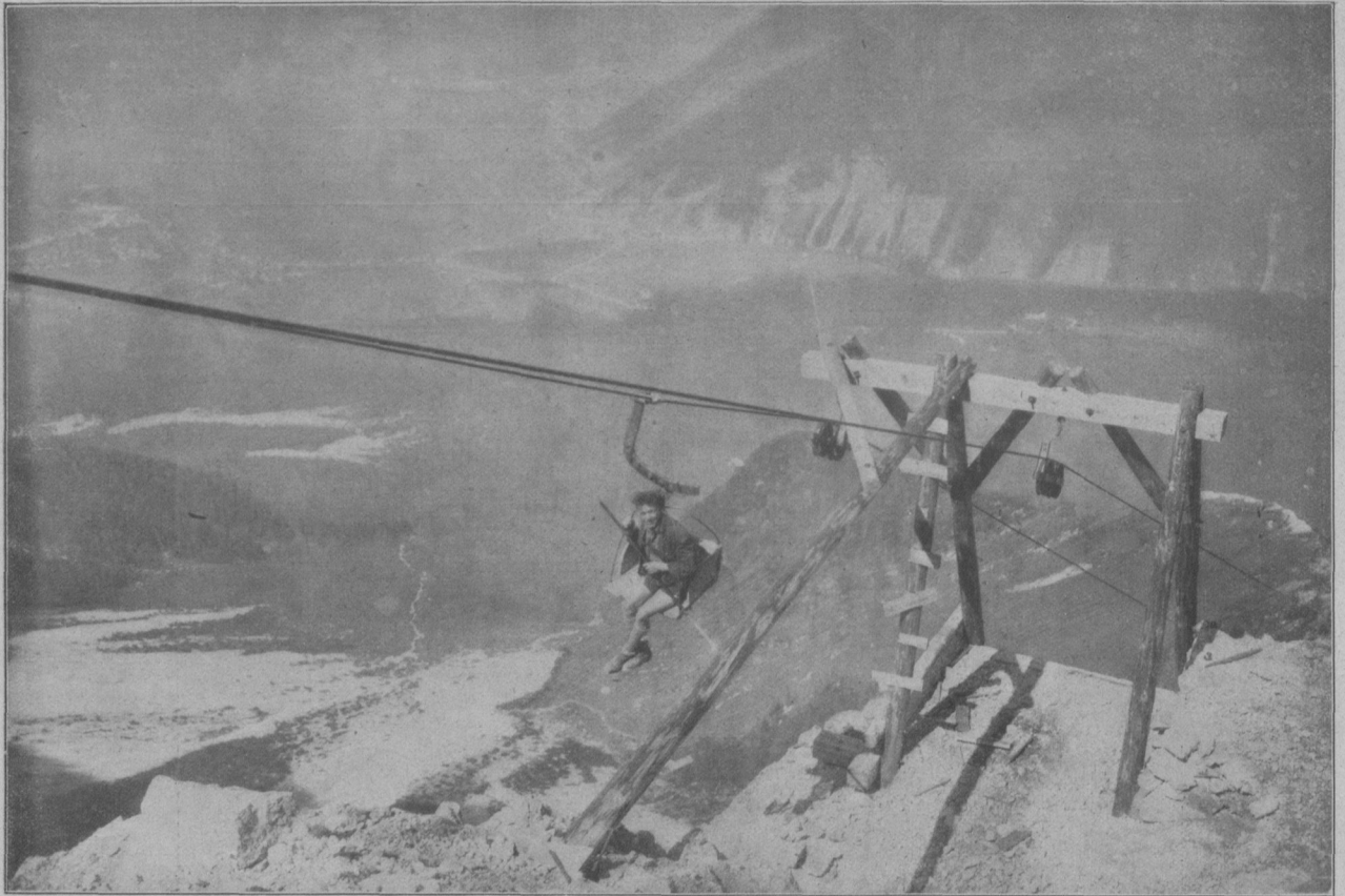
Vom Bahnbau auf der Zugspitze: Ein Ingenieur auf waghaltiger Schwebefahrt zur Arbeitsstätte.
