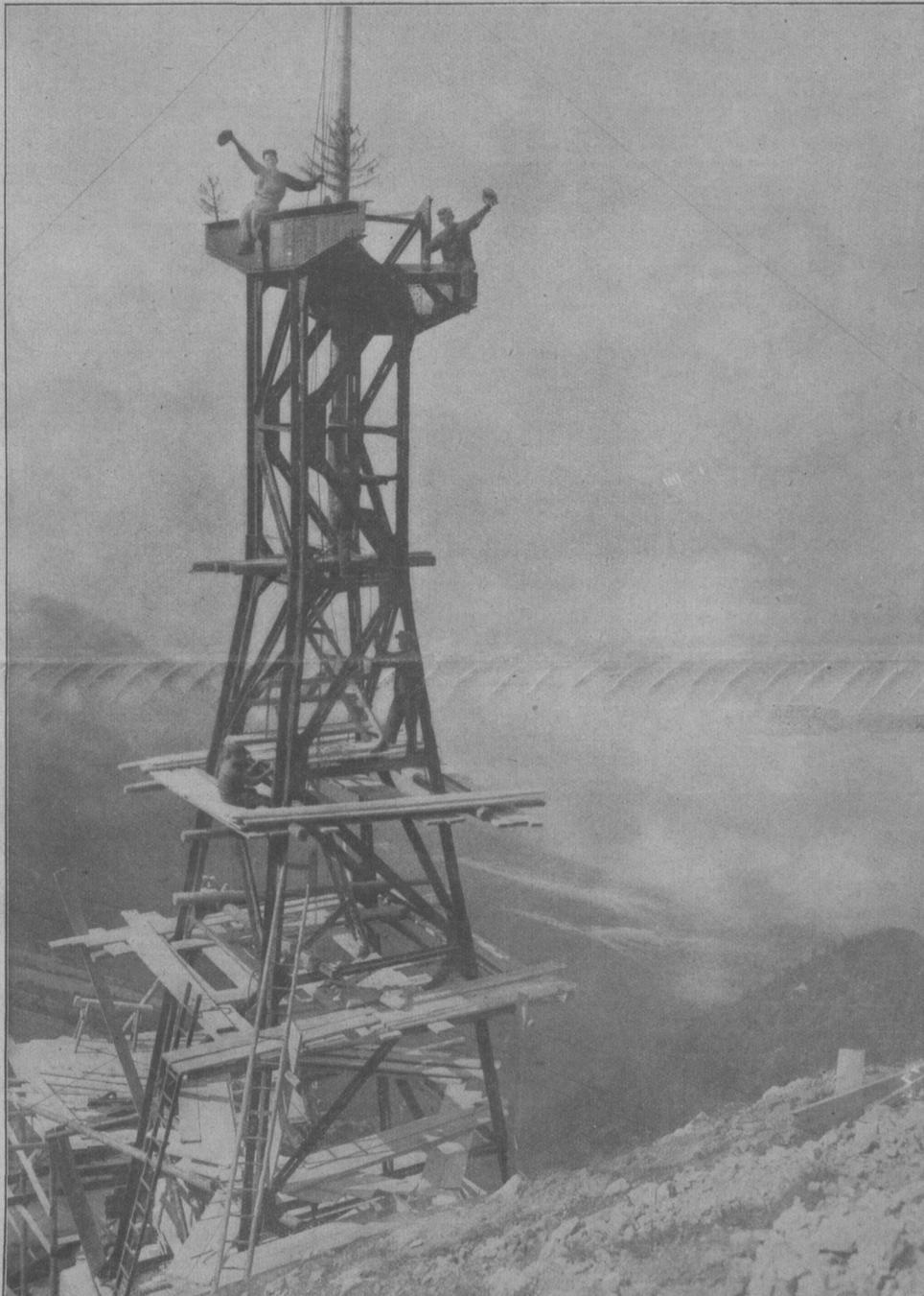
• Beim Bahnbau auf der Zugspitze: Errichtung einer Stütze für die Drahtseilbahn in über 2000 Meter Höhe.
