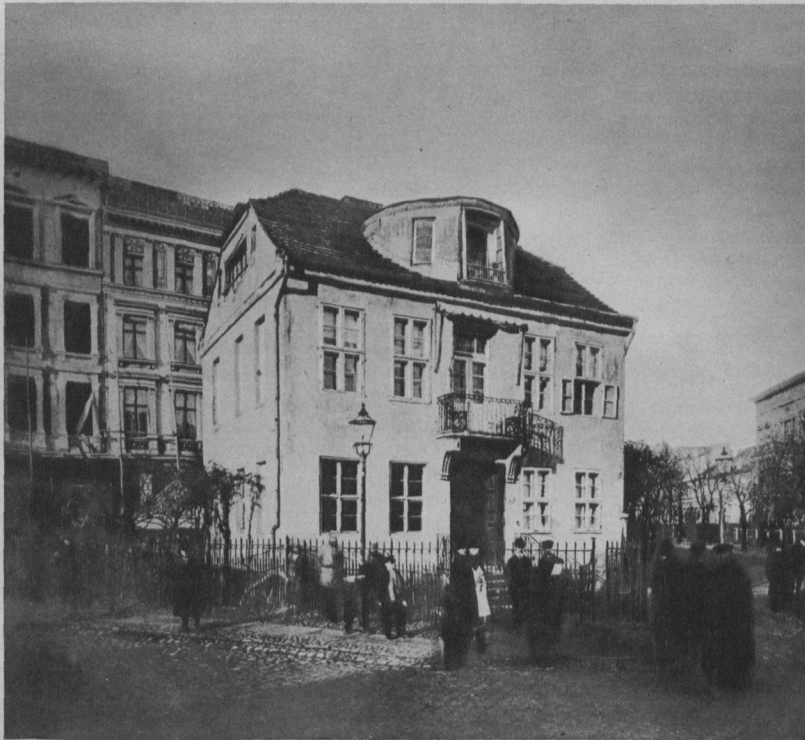
Nicht wiederzuerkennen: Das Haus mit der Ringischen Apotheke am Potsdamer Platz, das 1879 abgebrochen wurde. Heute steht an der Stelle das Jostyhaus.
