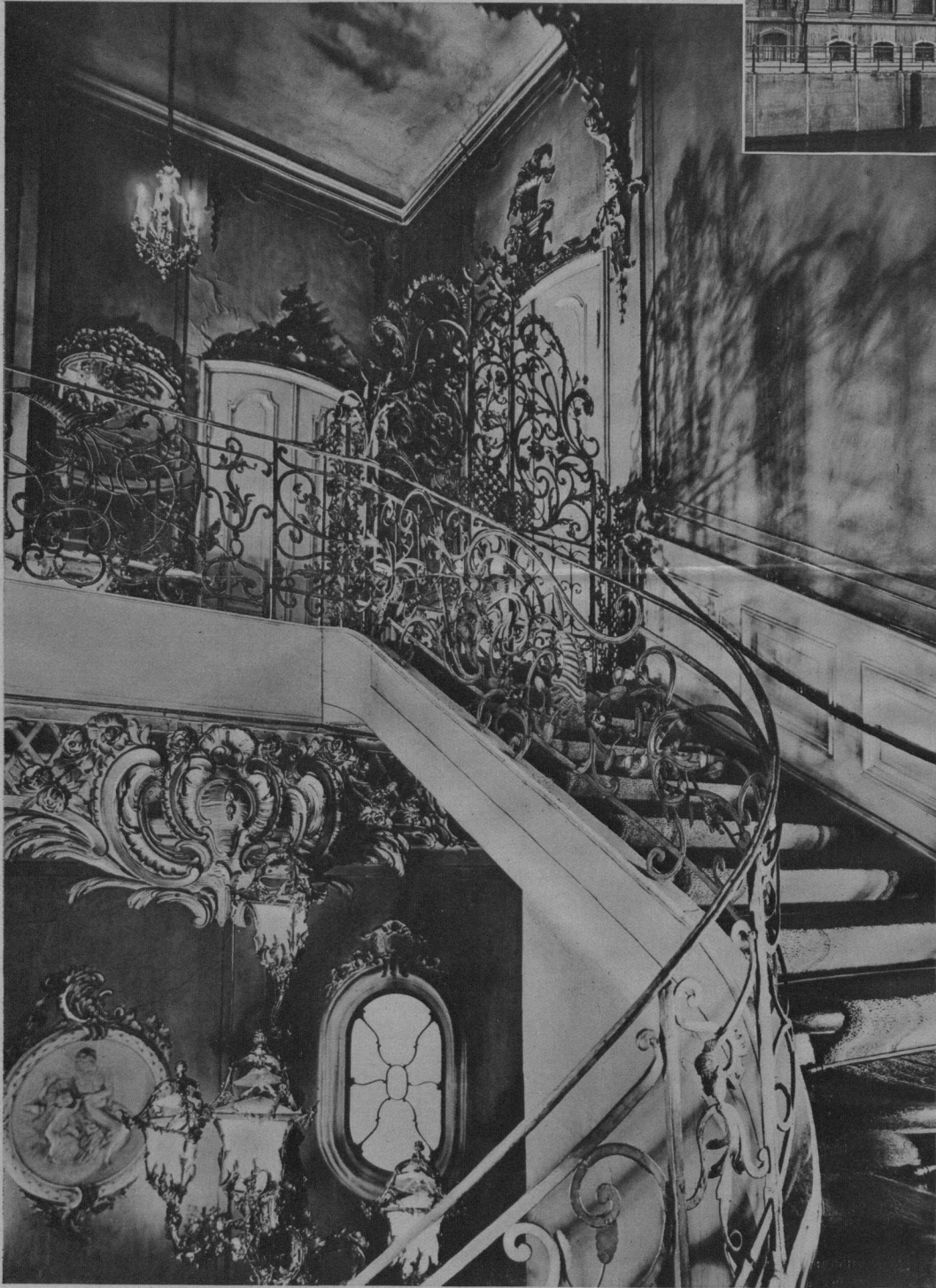
Ein wenig bekanntes Architekturjuwel in Berlin: Das Treppenhaus mit schmiedeeisernen Gittern im Hause Friedrichsgracht 58, im Besitz von Frau Lilli Lenz-Schwanzara. Aufnahmen: Zander & Labisch.
