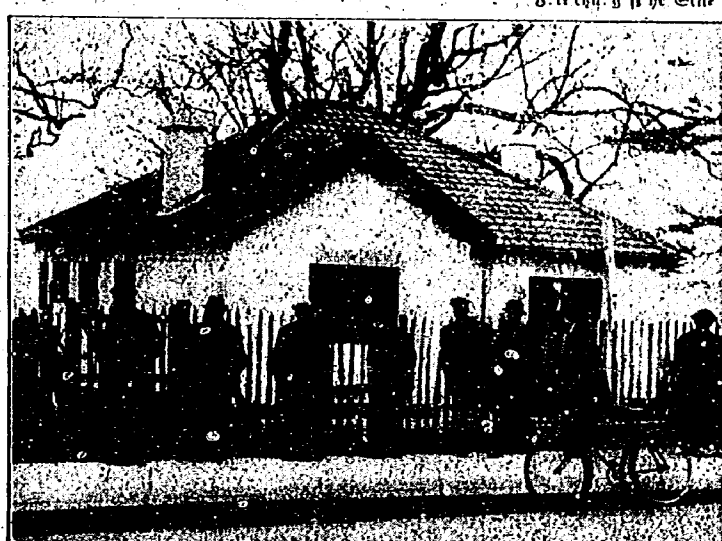
Stahlhäuser zur Lösung der Wohnungsnot. In England werden neuerdings Häuser gebaut, deren Gerüst und Mauern aus Stahl gefertigt sind. Die unschätzbaren Vorteile dieser Häuser liegen in ihrer Billigkeit und in der Schnelligkeit, mit der sie gebaut werden (in 3 Wochen). Der Preis ist so gering, daß auch ein sparsamer Arbeiter sich ein solches Haus kaufen kann. Press-Photo
