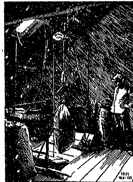
Auch am Dachboden läßt die Doppelwinde sich sehr einfach anbringen. Unten steht noch die alte Handwinde, die früher zum Heben der Säcke, benutzt wurde.
