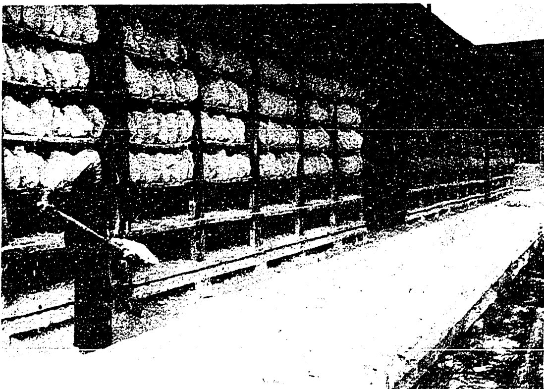
Die Kreide wird in Bündeln zum Trocknen in große Ständeranlagen geschichtet
