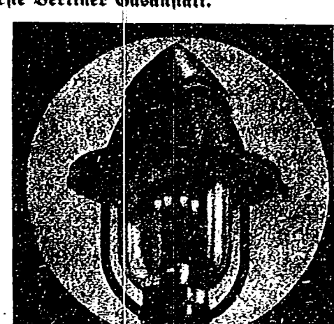
Die modernste Verwendungsart des Gasglühlichtes. Die feinen, gruppenförmig angeordneten Quer-Glühstrumpfe der Straßenbeleuchtung am Kurfürstendamm in Berlin.
