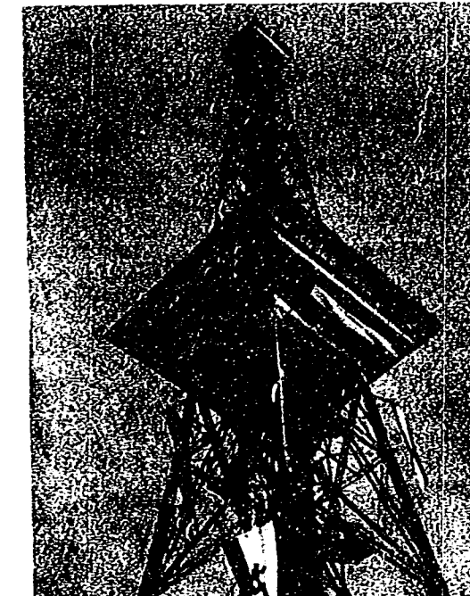
Der jetzt eingeweihte 138 Meter hohe Funkturm in Wühlleben.
