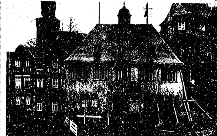
Ein großer Felssturz auf das Rathaus von Gföhlen im Tauern bröckelte dessen hintere Wand ein und hob es um 25 Zentimeter nach vorn. Man versucht, das geschichtliche Bauwerk durch Stützen zu retten. — Im Oval die Felsblöcke, die sich in die Hinterseite des Gebäudes gehoben haben. [Paul Lamm]
