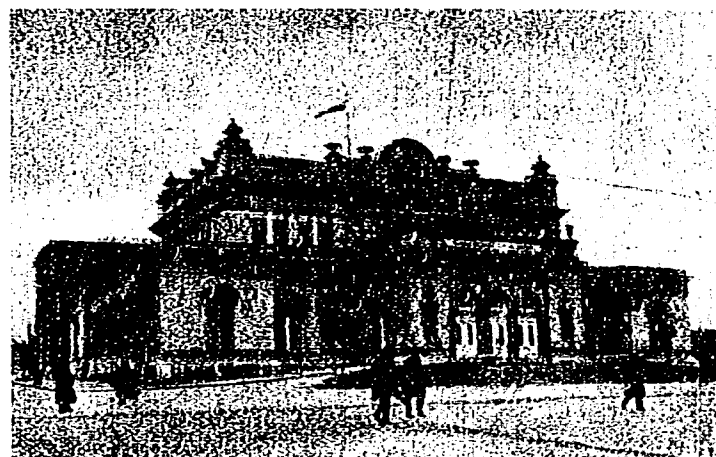
Die Sobranje, das bulgarische Parlamentsgebäude in Sofia.
