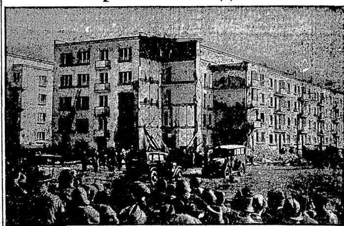
Часть дома, разрушеннаго взрывомъ свѣдильнаго газа.
