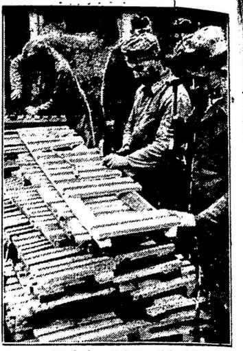
(Aufnahme PK-Jäger-Scherl-Autoflex) Holzroste für die Gräben an der Front. Ein Bild aus einer Pionierstrecke an der Westfront, wo gerade Grabenroste aus Holz hergestellt werden, die das Gehen und Stehen in nassen Gräben erleichtern. Auch hier wird solide Werkmansarbeit geliefert
