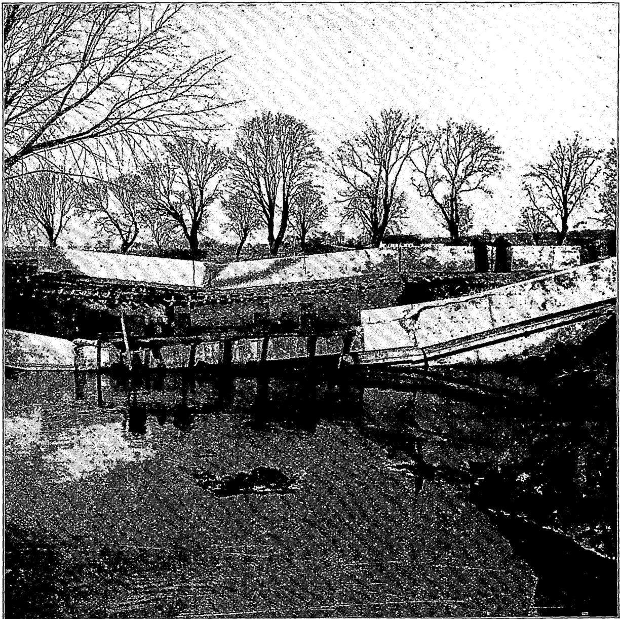
Der Brückeneinsturz bei Liebenwalde (Mark)
