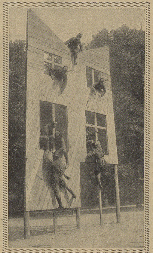
Das „provisorische Haus“: Eine neue Einrichtung für die Ausbildung der Schutzpolizisten bei Unruhen. Phot. A. B. C.
