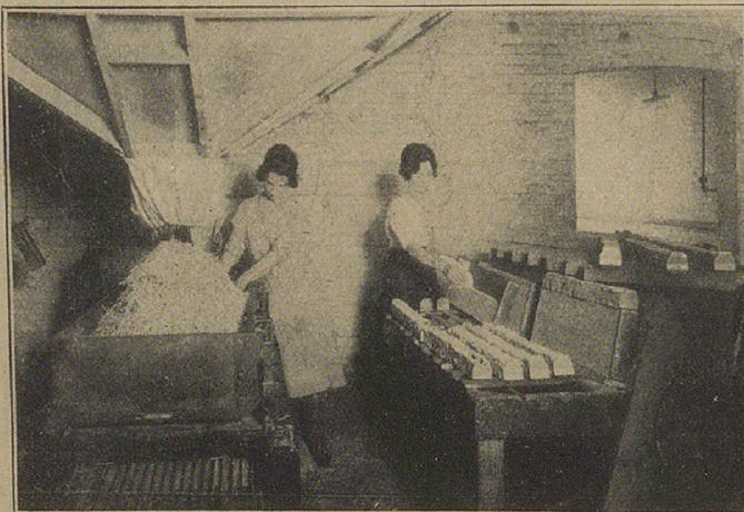
Die Streichhölzer fallen aus dem Trockenapparat auf ein Sieb, auf dem sie sich büstenartig aufstellen.
