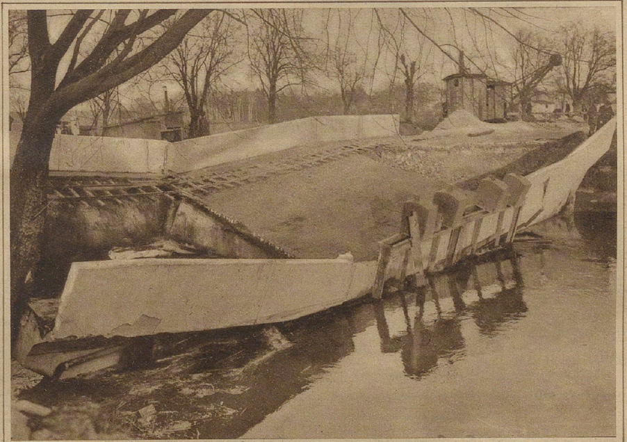
Die eingestürzte Eisenbetonbrücke bei Liebenwalde, die im Zuge der Chaussee Liebenwalde-Neuholland über den Zweigkanal führt
