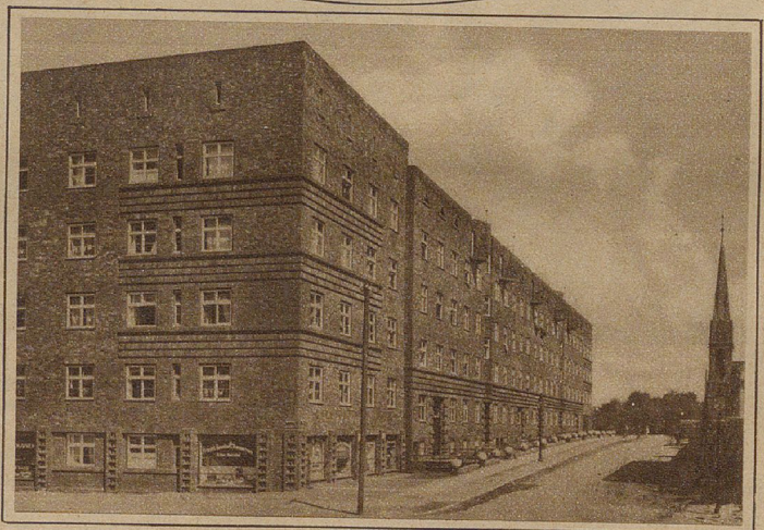
Der moderne Zweckbau , nach ausschließlich praktischen Gesichtspunkten erbaut Im Dva! Die heutigen deutschen Notbauten, Mangel an Geld und Zeit
