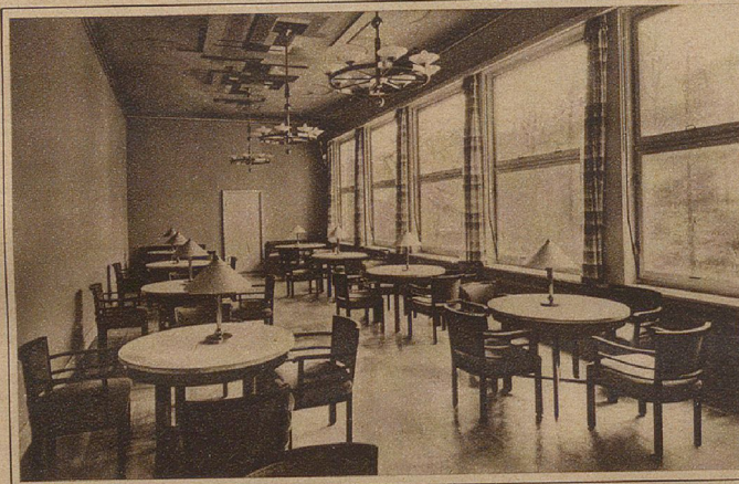
Licht durchflutet den Speisesaal, dessen hohe und breite Fenster Ausblick auf einen herrlichen Park gestatten
