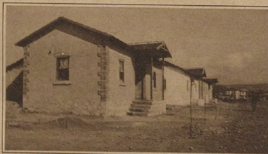
So sehen die neuen Flüchtlingshäuser aus
