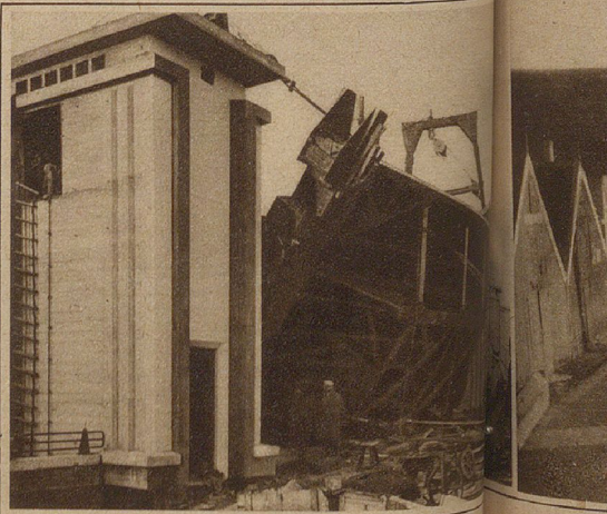
Eine der gigantischen Fördermaschinen, die den für den Dammbau notwendigen Geschiebemergel vom Meeresboden heraufholen
