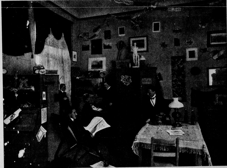
Ein Blick in die alte »Pepiniere« in Berlin, die demnächst abgerissen wird.
