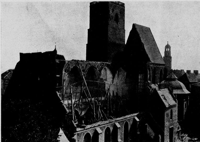
Der Einsturz des Giebels auf der Schlosskirche zu Oels.
