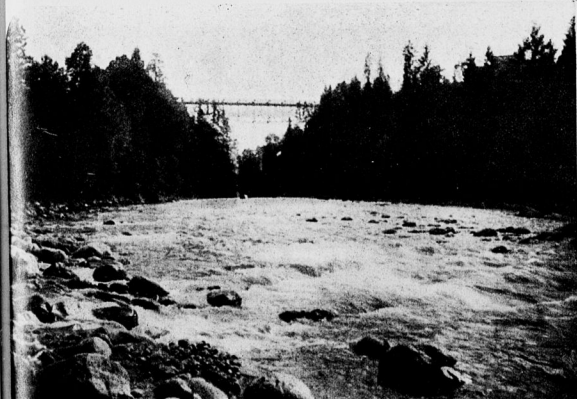
Eiserne Flussbrücke über die Bregenser Ache bei Egg.
