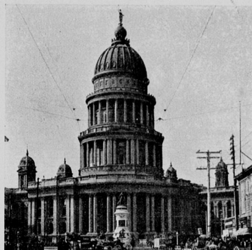
Die Stadt-Halle von San Francisco, die mit Dynamit gesprengt wurde.
