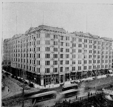
Das Palace-Hotel in San Francisco, einer der grössten Hotelbauten der Welt, brannte nieder und begrub zahlreiche Bewohner unter seinen Trümmern.
