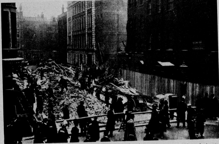
Der Hauseinsturz in London.
