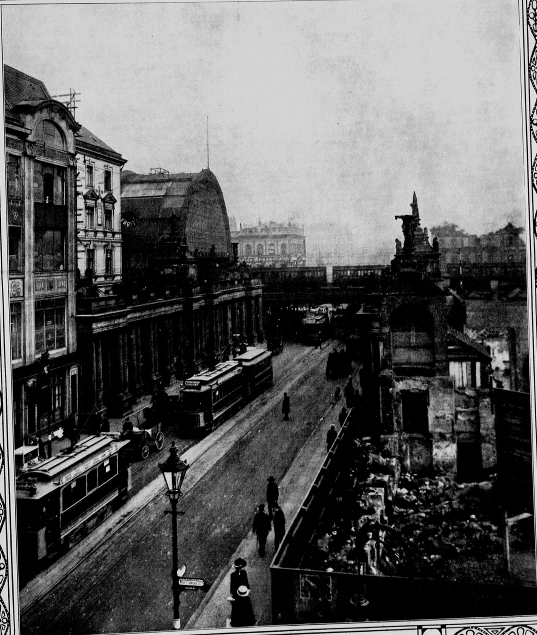
Ein schwindendes Stück Alt-Berliner Architektur: Die zum Abbruch bestimmten Königs-Kolonnaden.
