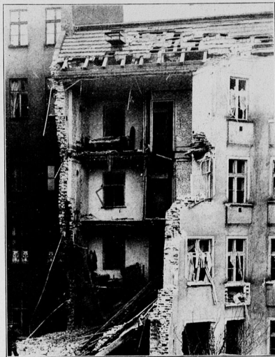
Der Hauseinsturz in Breslau. A. Noht cop. Das durch eine Gasexplosion zerstörte Haus in der Einbaumstraße, unter dessen Trümmern drei Personen begraben wurden.
