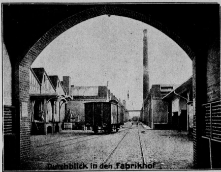
Durchblick in den Fabrikhof
