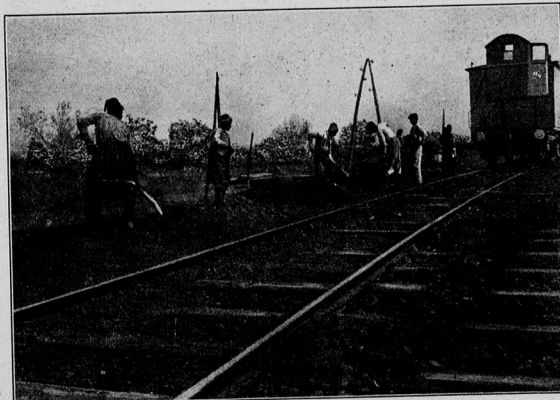
Armenische Arbeiter beim Bau einer Strecke der Bagdad-Bahn. Mavrides phot.
