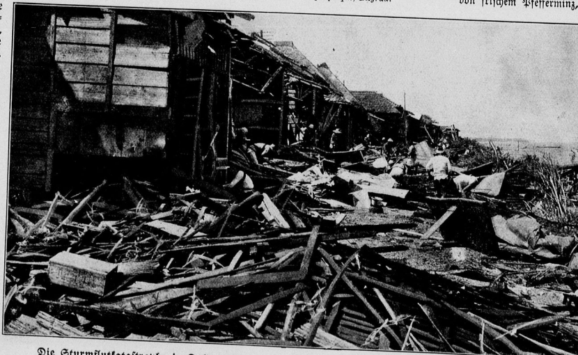
Die Sturmflutkatastrophe in Tokio: Blick in das durch das Unwetter zerstörte Stadtviertel.
