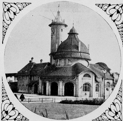
Bahnhof Zehlendorf-West (Zehlendorf-Beerenstraße)
