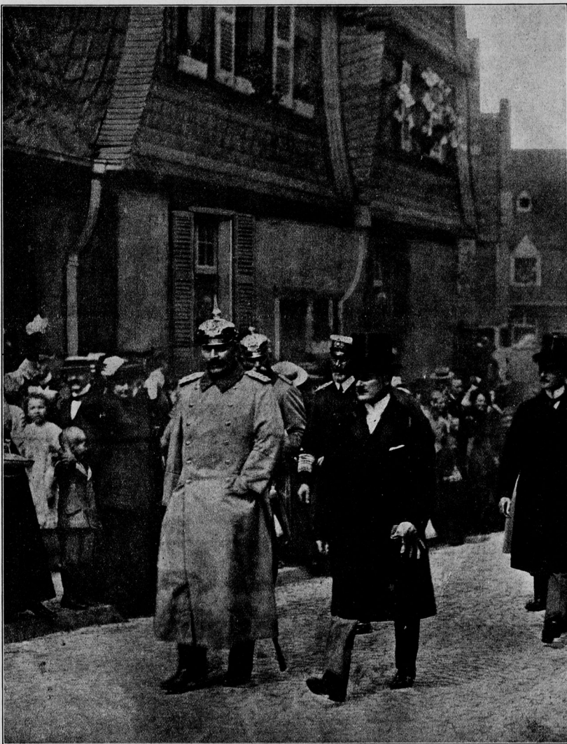
Der Kaiser besichtigt in Begleitung Dr. Krupp v. Bohlen-Halbachs die Kolonie Margaretten-Höhe. Hinter dem Kaiser Prinz Heinrich.
