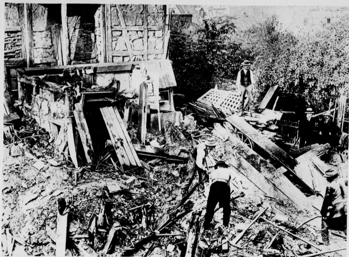
Die Trümmer des eingestürzten Hauses.
