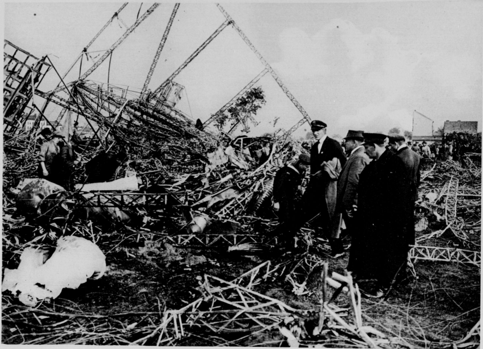
Die Katastrophe des Marine-Luftschiffes „L 2“ bei Adlershof. Unsere Aufnahme zeigt die Trümmer des völlig zerstörten Luftkreuzers unmittelbar nach der Explosion.
