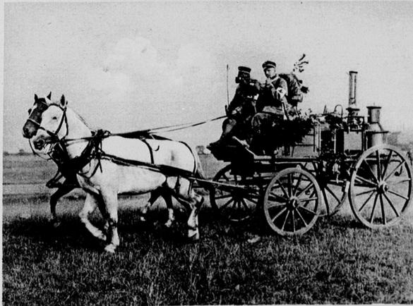
Fahrbarer Apparat zur Herstellung destillierten Wassers im Dienste des Roten Kreuzes. W. Brauner phot.
