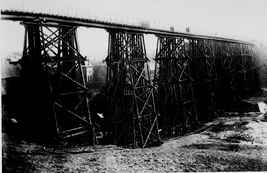
Die größte von unseren Pionieren bisher erbaute hölzerne Eisenbahnbrücke in Nordfrankreich.
