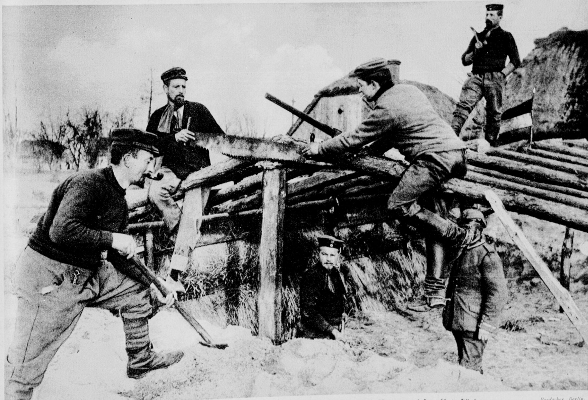
Vorbereitungen für den Winter an der Ostfront: Unsere Soldaten beim Bau von festen Unterständen.
