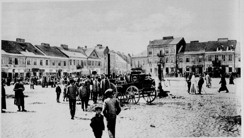
Reinfectes Trinkwasser für die Stadt Ploetz. Ein Filtrierapparat auf dem Marktplatz.
