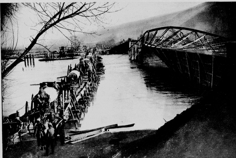
Eine von den Serben zerstörte Brücke über die südbische Morava; daneben eine von unseren Pionieren erbaute Vorbrücke.
