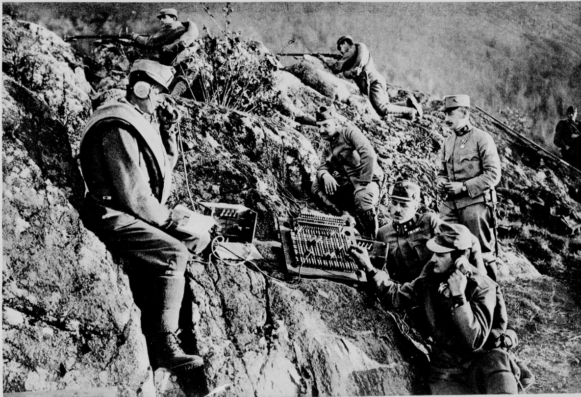
An der Dolomitenfront: Telephonzentrale während eines Gefechts.
