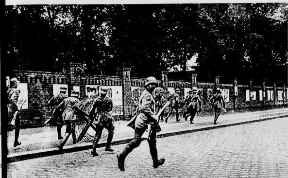
Straßensperretrupp in Tätigkeit.
