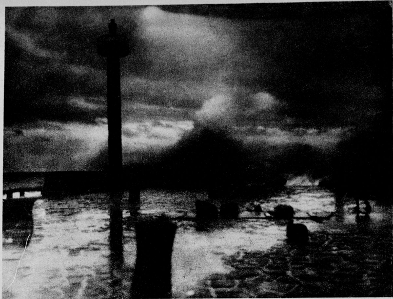
Sturmschäden in Kolberg.
