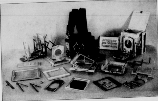
Spiegelreflexkamera (neuestes Modell) in ihren Einzelteilen.
